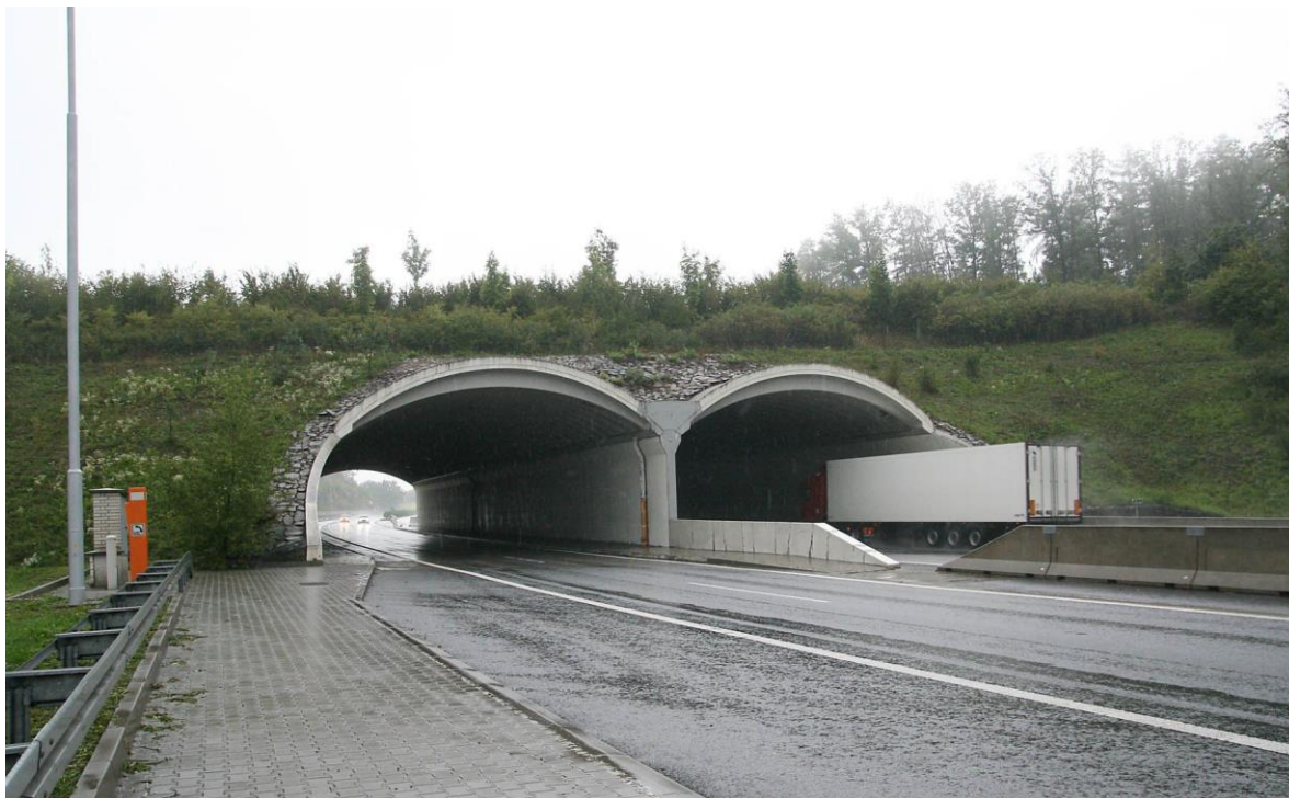
Obr. 2. Ekodukt Dolní Újezd v roce 2007
