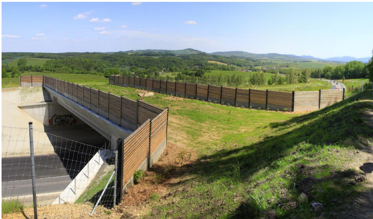
Obr. 9. Ekodukt Rozkoš na silnici I/13
